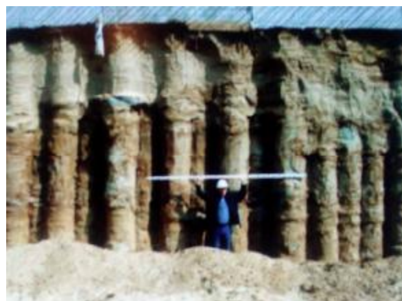
Slika 23. Strana temeljne jame stabilizovana "soilcrete" stubovima
