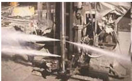
Slika 1. Raspršivanje veziva mlaznicama
