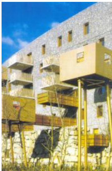
Sl. 5. u 6. Ulični izgled zgrade i detalj
