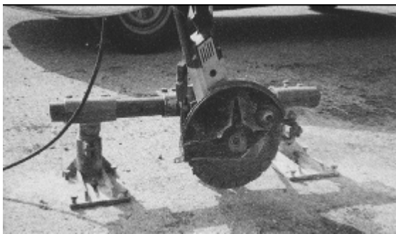
Slika 4. Prošlicavanje betonske konstrukcije [7]
