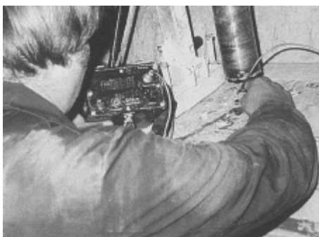
Slika 7. Vađenje kerna u cilju određivanja postojećeg stanja napona u betonskoj konstrukciji
