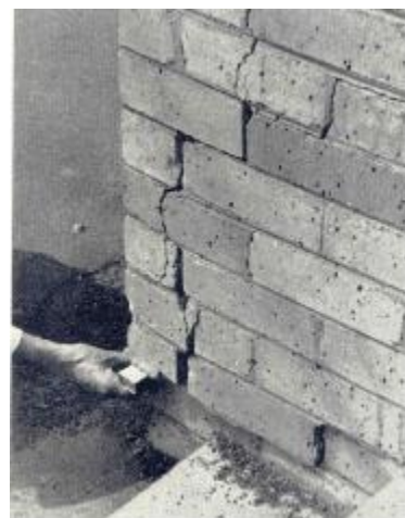
Sl. 8: Pomeranje drugog zida usled vlažnog širenja opeka
