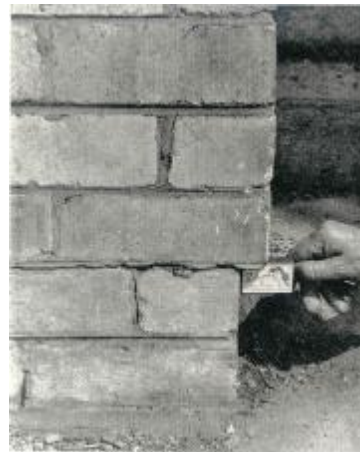
Sl. 7: Pomeranje zida od 2 cm usled vlažnog širenja opeka
