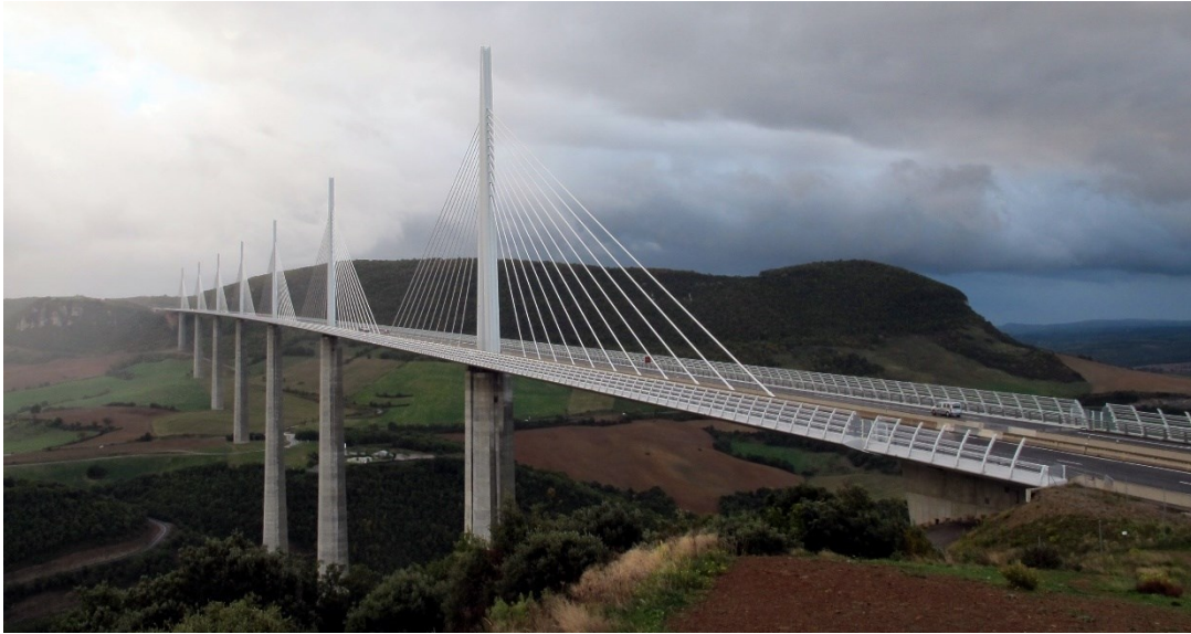
Figure 14. Viaduc de Millau (2015)
