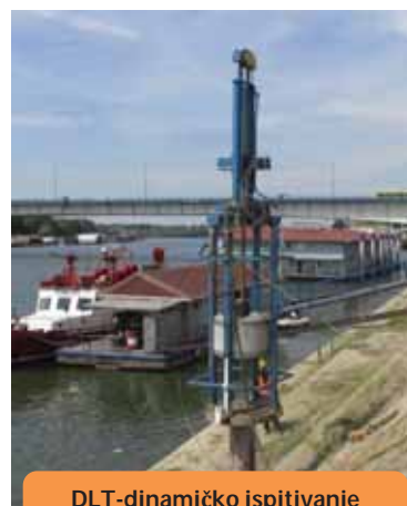
DLT-dinamičko ispitivanje šipova
