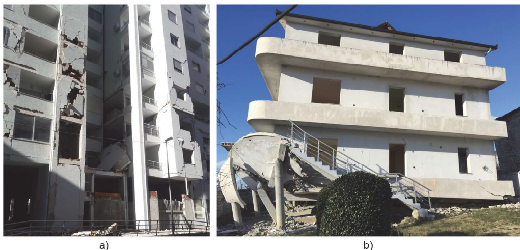
Slika 1. Novembarski zemljotres 2019. u Albaniji: a) kolaps zidova ispune; b) pojava „fleksibilnog prizemlja“ AB okvirne konstrukcije sa zidanom ispunom [5]
