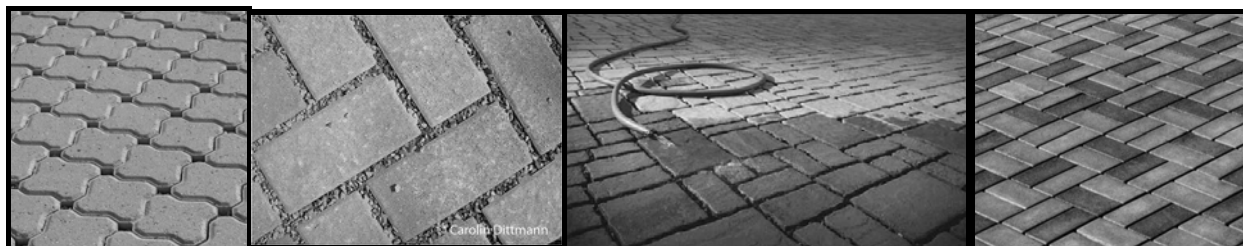
Slika 2. Propusni beton od elemenata sa žljebovima za spajanje [16,17,18,19] Figure 2. Permeable interlocking concrete pavements [16,17,18,19]
