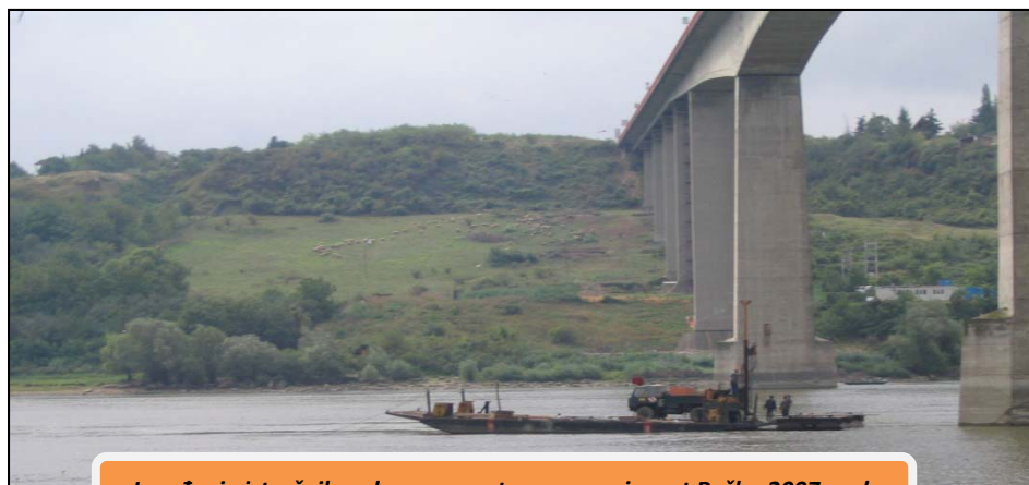
Izvođenje istražnih radova sa pontona za novi most Beška, 2007.god.
